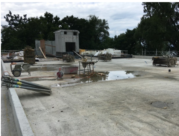
Deckenplatte des 1. OG, der späteren Dachterrasse des Attikageschosses fertig betoniert Anfang Juli 2022.
