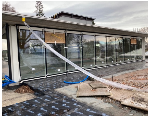
Windgeschützter Teil des Attikageschosses.
