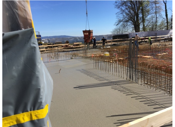
Betonieren der Deckenplatte des Untergeschosses.
