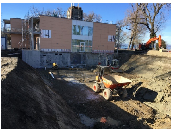
Aushubarbeiten Ostseite für Erweiterung.
