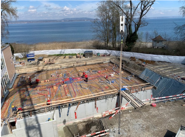
Deckenplatte des Untergeschosses armiert und Leitungen verlegt.
