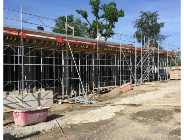
Erdgeschoss mit Stützen für Balkone.
