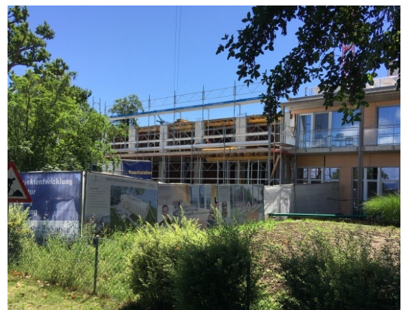
Aufbau des 1. OG und Schalung für Deckenplatte des 1. OG.
