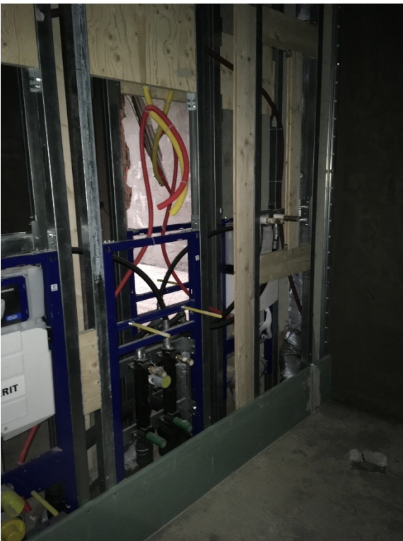
Bilder unten: Im Badezimmer sind die Sanitären Zuleitungen installiert. Die Bodenheizung wurde verlegt und die Unterlagsböden im November 22 erstellt.
