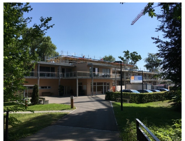
Attikageschoss fertig betoniert Ende Juli 2022.
