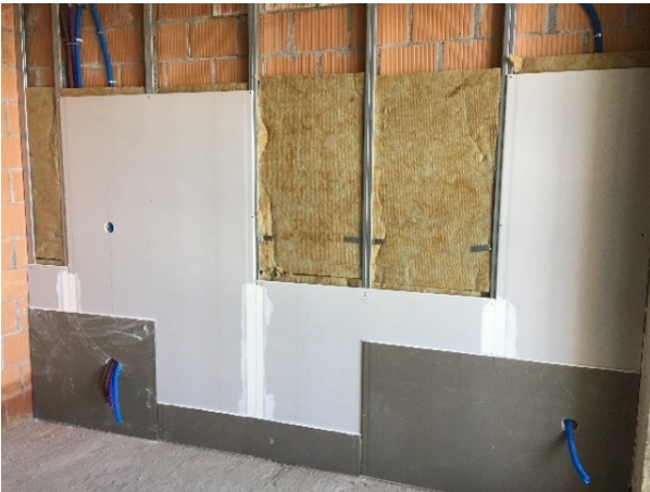
Bilder oben: Die Zimmerwände wurden im Oktober 22 isoliert und mit Gipsplatten verkleidet.
