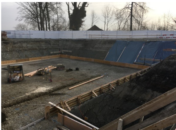
Aushub abgeschlossen, Vorbereitung für Bodenplatte.
