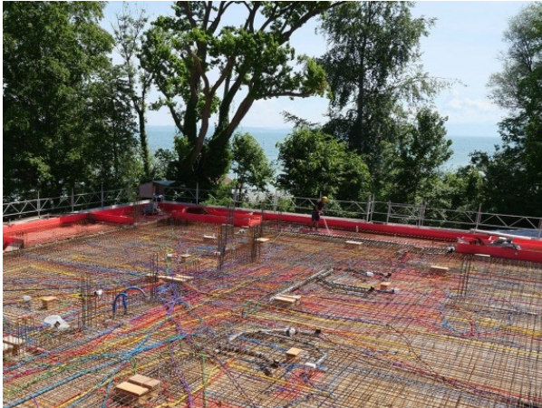
Armierung Deckenplatte Erdgeschoss.
