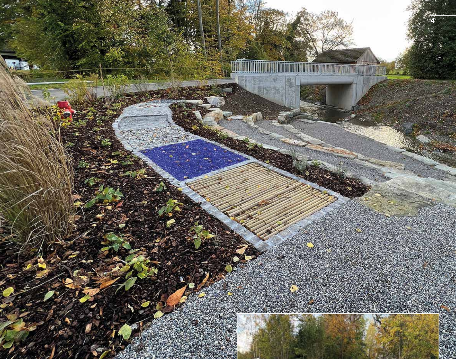
Neue Brücke mit Barfussweg
