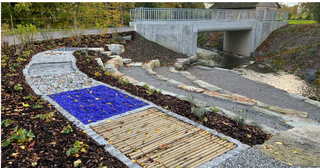
oben: neue Zufahrtsbrücke zum Gesundheitszentrum Sokrates, unten: Barfussweg
